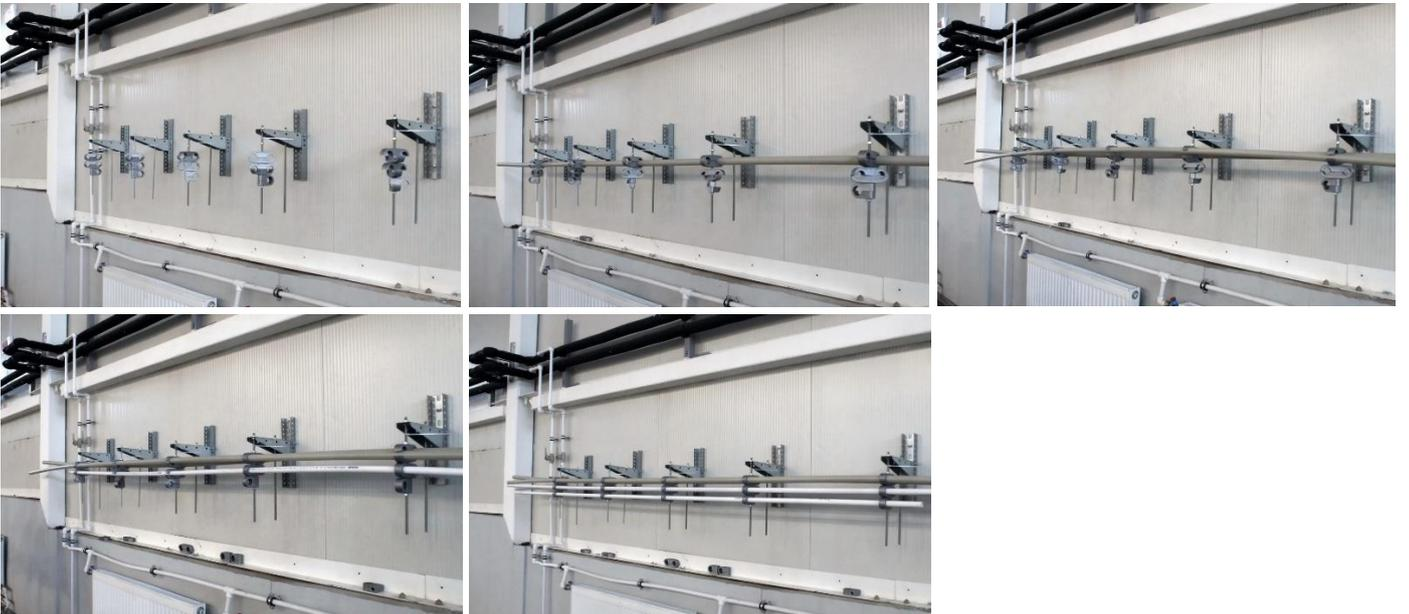
В результате получаем надежно уложенную систему труб со скользящей фиксацией, стабильным уклоном, заданным однократно и автоматически выдержанным для всей группы труб. Подобная система проста в обслуживании: легко и быстро может быть заменена отдельная труба, а также добавлены дополнительные трубы в магистраль.
