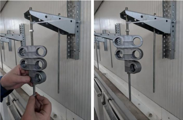
6. Укладываем поочередно трубы в пластиковые крепления, по окончанию плотно зажимаем нижней гайкой.
