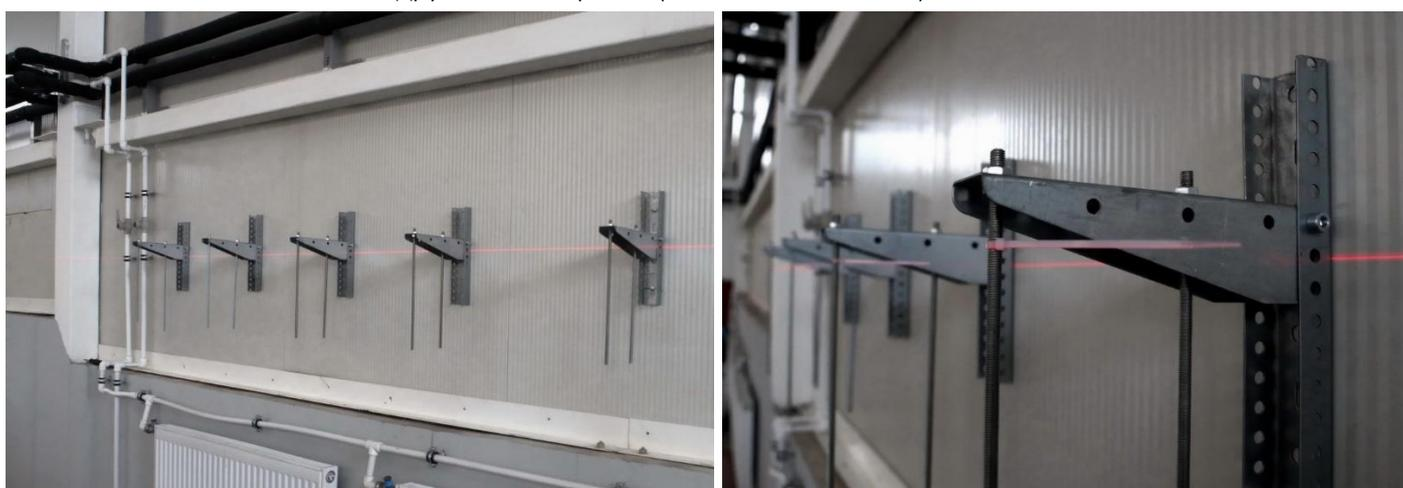
4. На первом кронштейне накручиваем гайку до уровня отметки, далее, в соответствии с нужным уклоном, гайка накручивается ниже на каждом следующем кронштейне. В нашем примере делаем уклон 1% (1 см на 1 метр), соответственно на каждом следующем кронштейне (через 0,5 м) опускаем гайку на 0,5 см ниже предыдущей.
