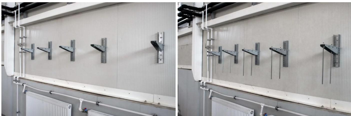
3. Используя луч оптического нивелира (просматривается на фото красная линия), делаем отметки уровня на шпильках с использованием подручного материала (пластиковые стяжки):
